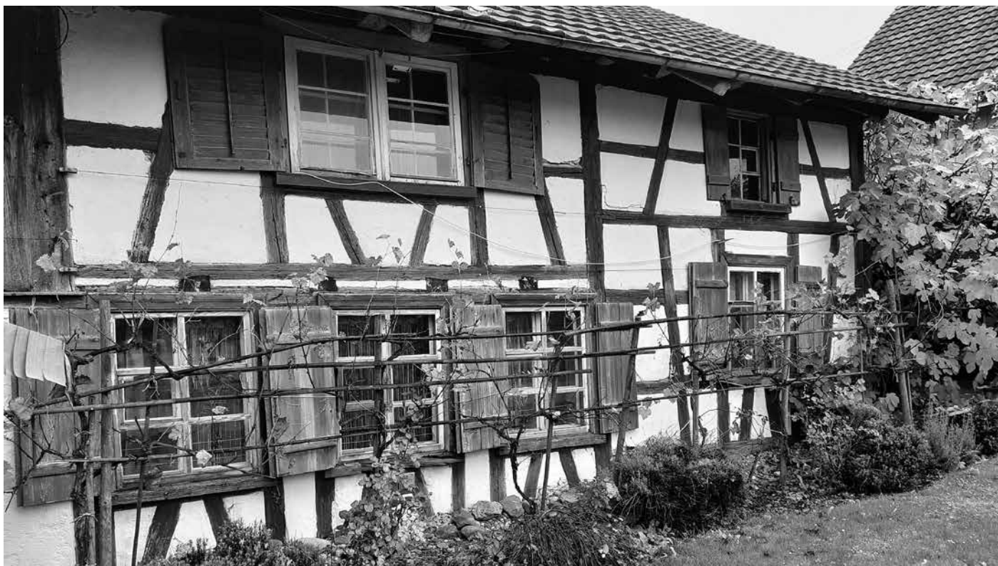
Altnau, Unterdorfstrasse 18: Dieses Gebäude müsste dringend restauriert werden. Aus unserer Sicht ein klares Schutzobjekt, auch aufgrund seiner Einbettung in die umliegenden historischen Bauten.
