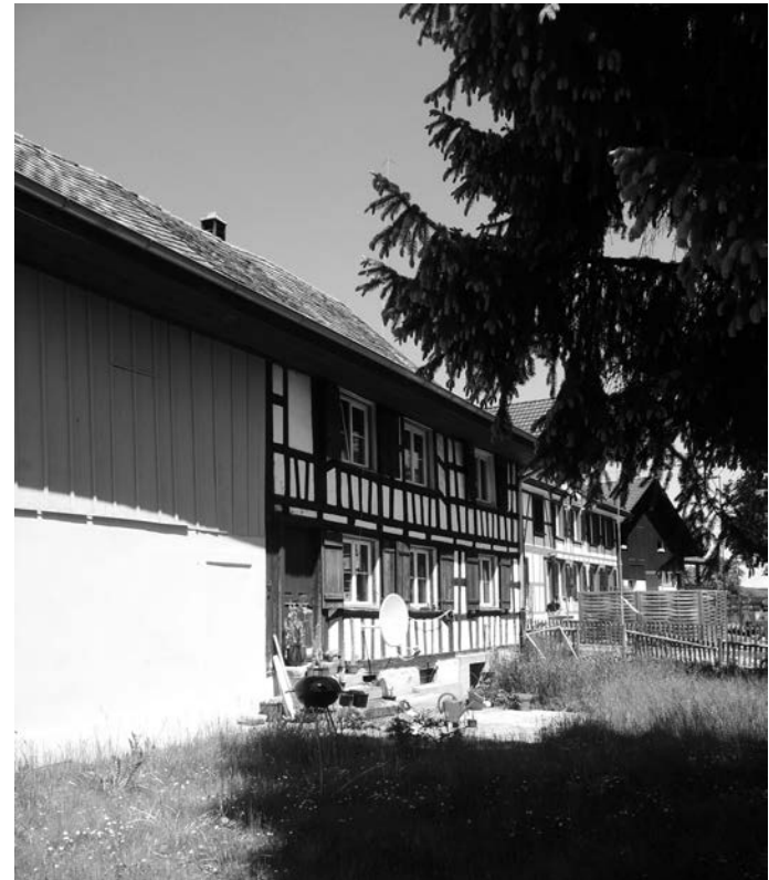
Dieses Bauernhaus in Zihlschlacht, untere Hagenwilerstrasse, muss leider einem Wohnblock weichen.
